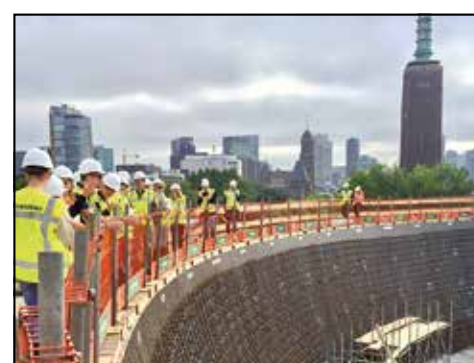
Depot Boijmans Van Beuningen in aanbouw. Foto: Mieke Vullings
