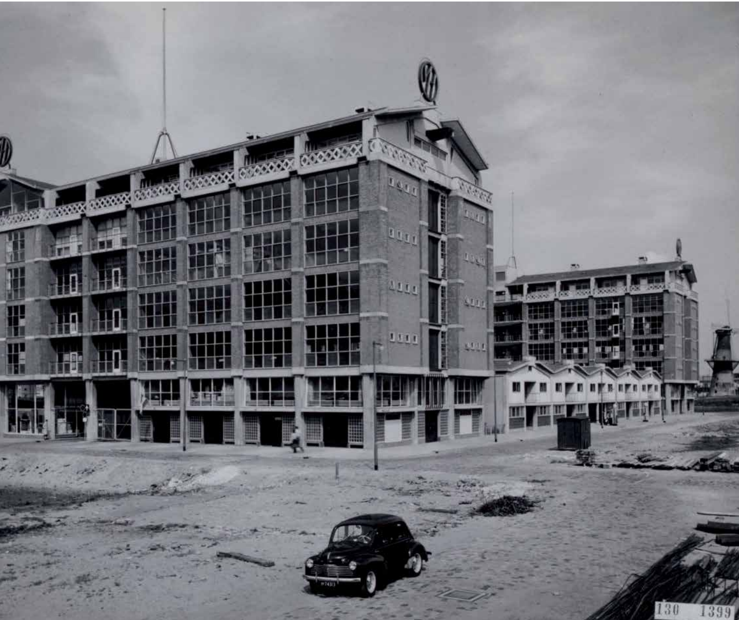
Het Industriegebouw vlak na de oplevering in 1949
